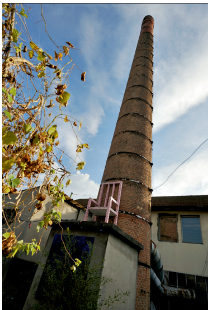
La très haute et étroite cheminée de briques rouges qui signale l'usine et la Jonction loin à la ronde.
